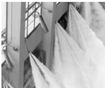
Rys. 5. Hybrydowa instalacja pianowo-proszkowa w budynku Źródło: Internet
